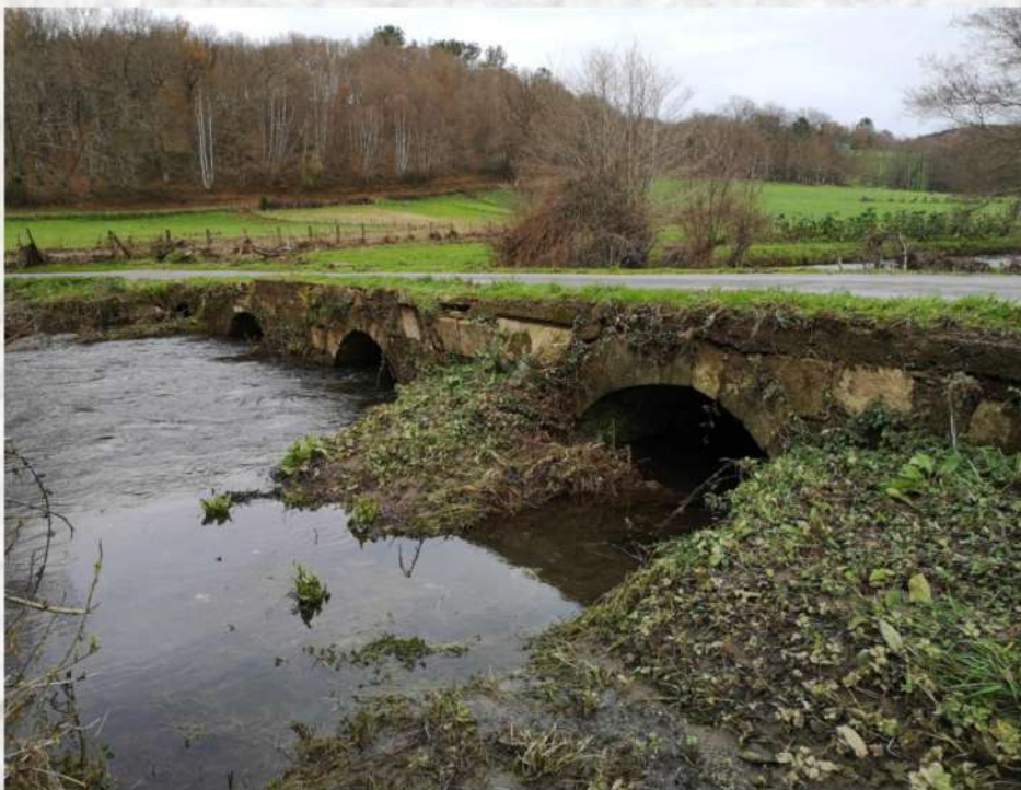
Fotografía: Pontenoufe, unha ponte de catro arcos JLRJ.
